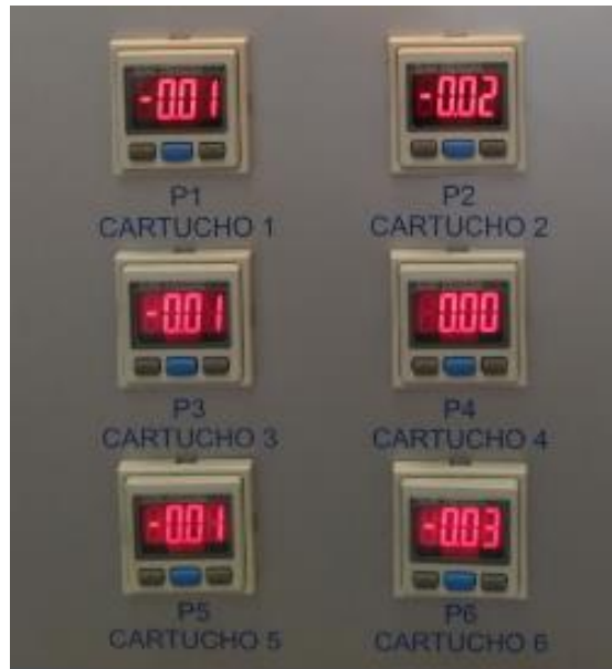
Figura 6-4 Pressostatos
